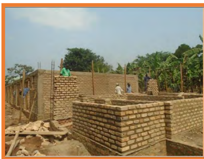
9 en 10 Het optrekken van de muren
