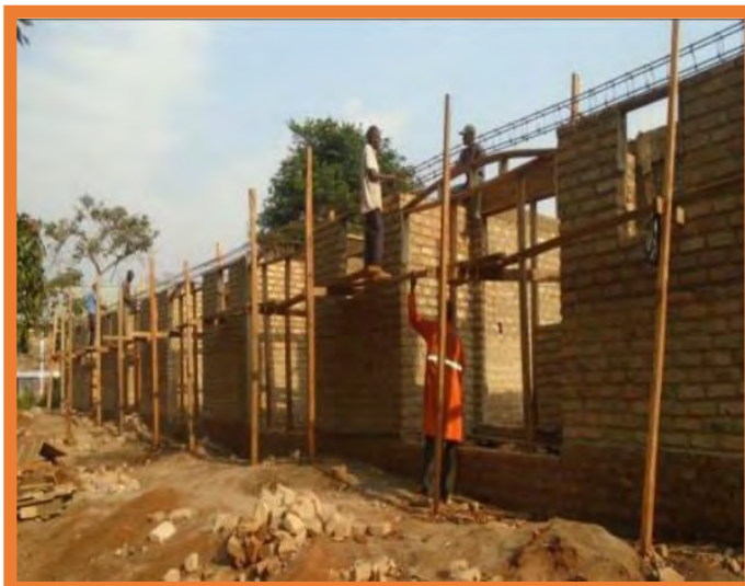
9 en 10 Het optrekken van de muren
