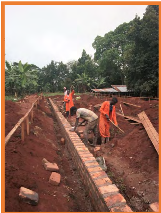
8 Het leggen van de fundering
