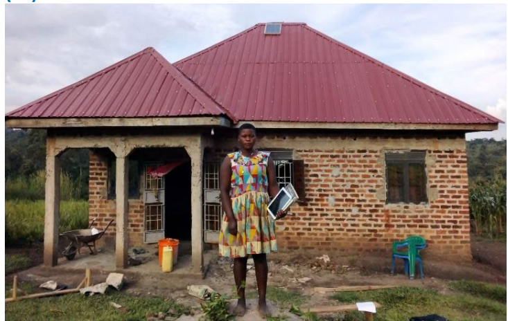
14: Installatie van zonnepanelen op het huis van Joseline (S4)
